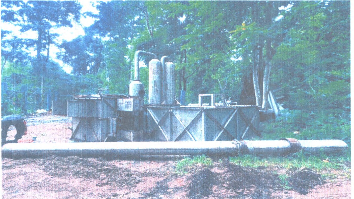
เตาเผาขยะประกอบด้วยเตาเผาขยะแบบดักเก็บมลพิษ รุ่น PTN-๑๐ พร้อมอุปกรณ์
